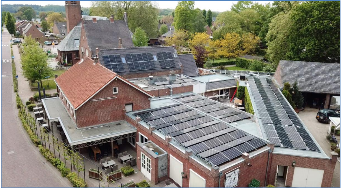
Figuur 7: Esbeek Schuttershof zonnepanelen
